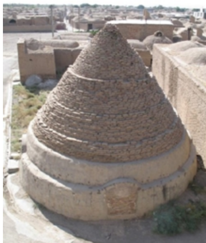
تصویر ۱۵) نمایی از مخزن آب انبار حسینیه قبل از مرمت
