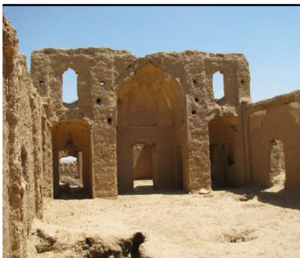
تصویر ۶) نمای داخلی قلعه عزیزآباد
