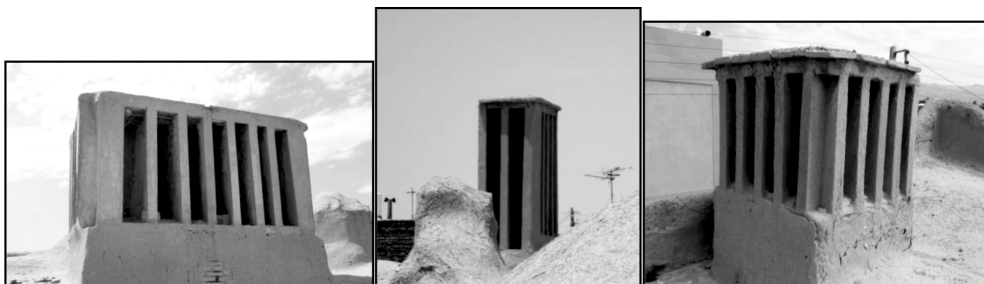
تصویر ۱۱) بیرجند، بادگیر گونه‌شناسی براساس فرم دهانه مربع، مستطیل افقی و مستطیل عمودی (مآخذ: نگارندگان)
