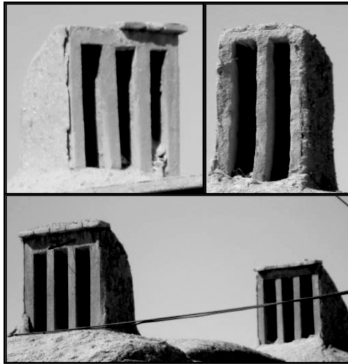
تصویر ۱۳) نمایی از بادگیرهای یک طرفه خوسف (مأخذ: نگارندگان)
